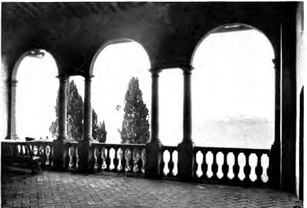
WEST LOGGIA. FIRST FLOOR—VILLA DEI COLLAZZI, TAVARNUZZE, TUSCANY.
