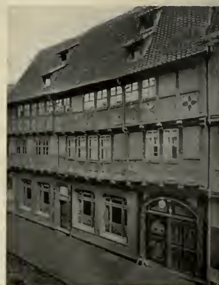
Fig. 19. Die Rose (Breitestrasse), Original Condition, Quedlinburg, 1612.
