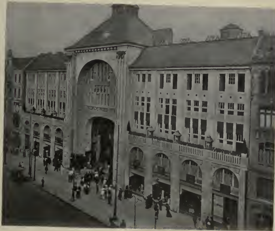
Passage Kaufhaus (Friedrichstrasse-Passage)
