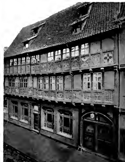
Fig. 19. Die Rose (Breitestrasse), Original Condition, Quedlinburg, 1612.
