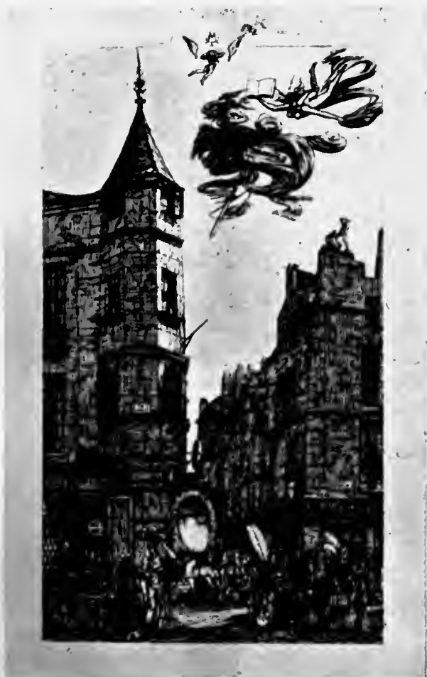
TOURELLE, RUE DE L'ÉCOLE DE MÉDECINE.
