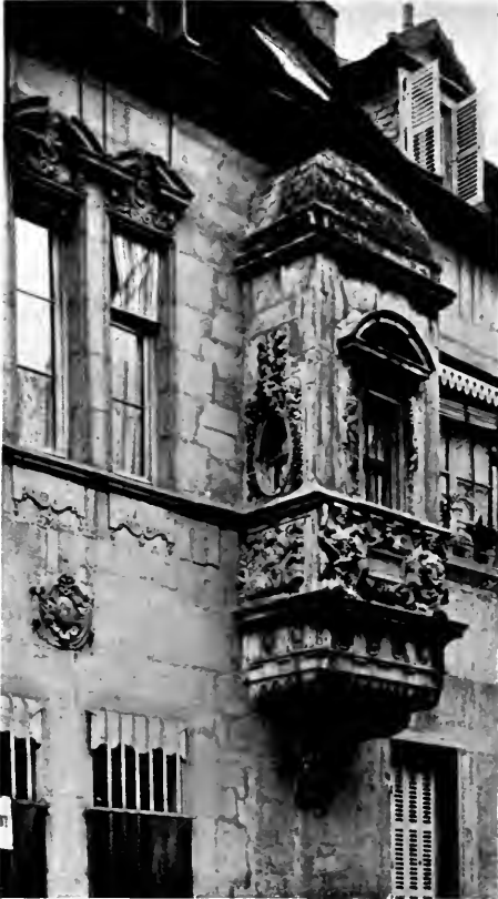
157. DIJON: ORIEL, 37 RUE DE LA VANNERIE.
