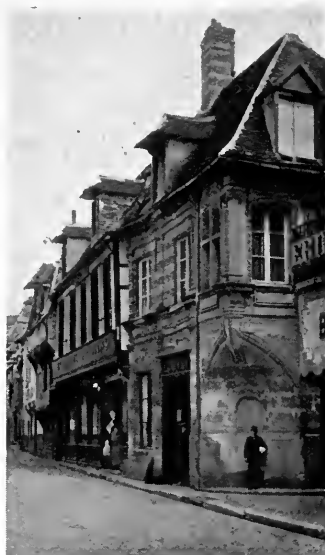
134. BEAUVAIS: “MAISON DU PONT D’AMOUR.”
