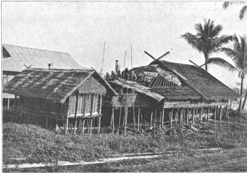
Dachdecken im Dorf Kenghkam, südl. Shanstaat Yawnghe.
