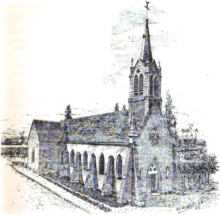
ÉGLISE DE SAINT-DENIS-LES-PONTS
