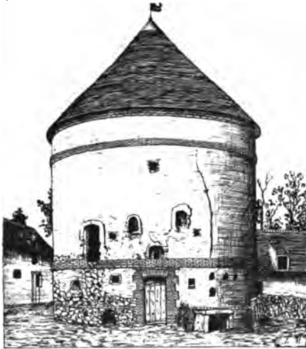
COLOMBIER D'ORVILLIERS avant sa restauration en 1896.
