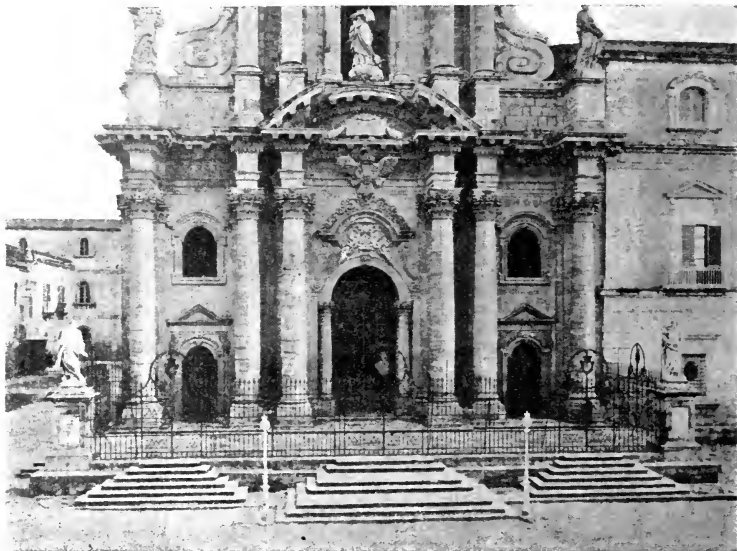
Fig. II. — Facciata del Duomo. Particolari.
