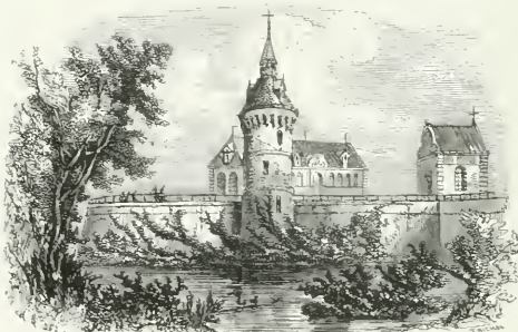
Vue du château et de la chapelle de Bellaing
