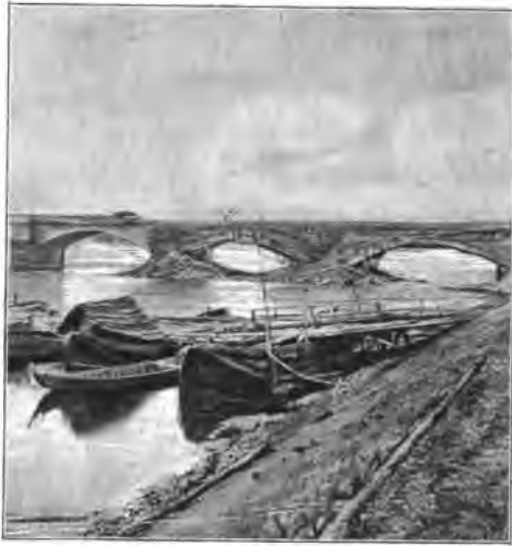
Die große Ticinobrücke nach der Sprengung.
