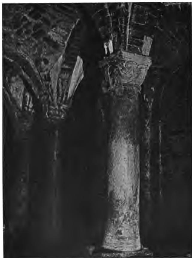
Particolare della cripta dopo i lavori eseguiti nel 1905.
