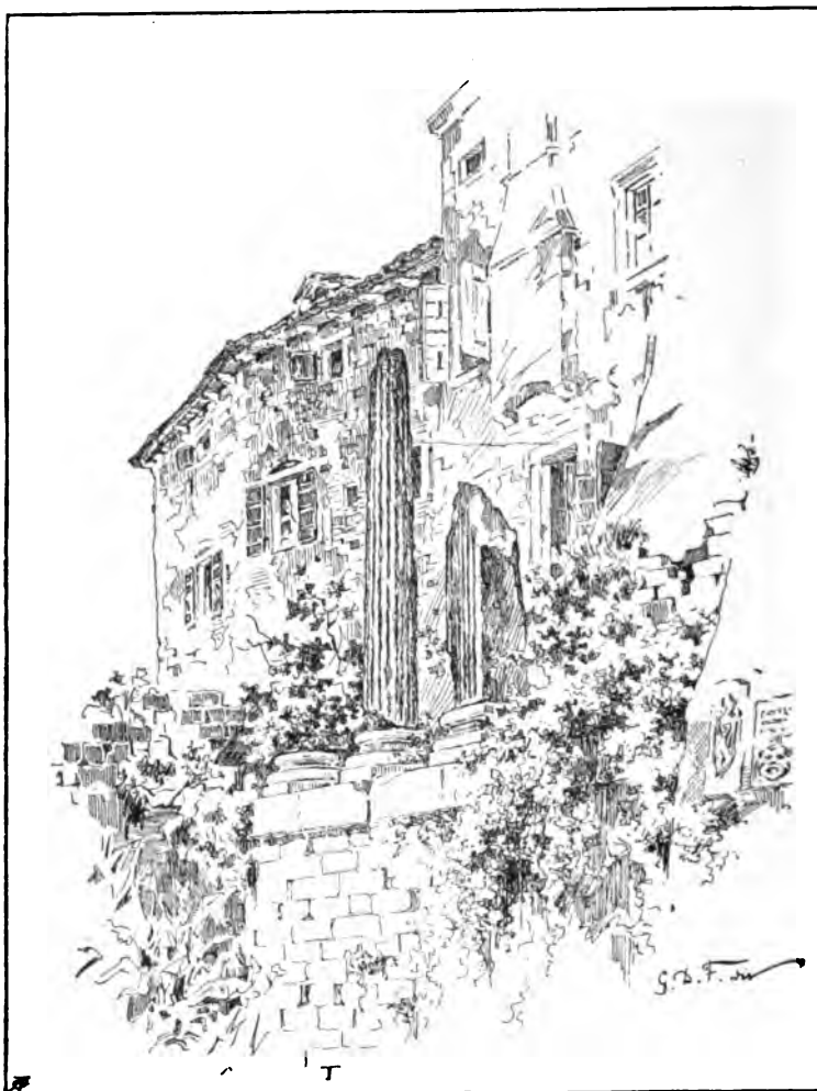
fig. 13. — Residui del tempio di Nettuno.
