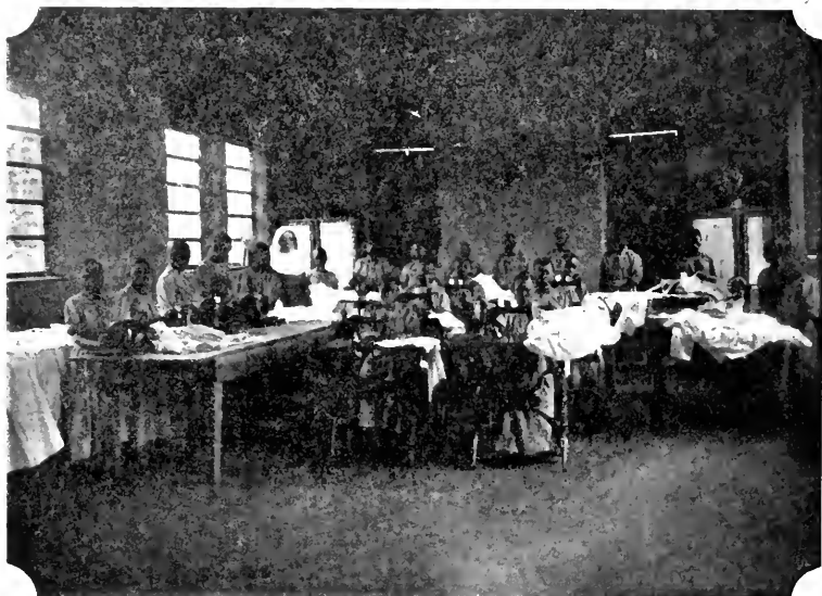
L'OUVROIR AU BATIMENT SCOLAIRE
