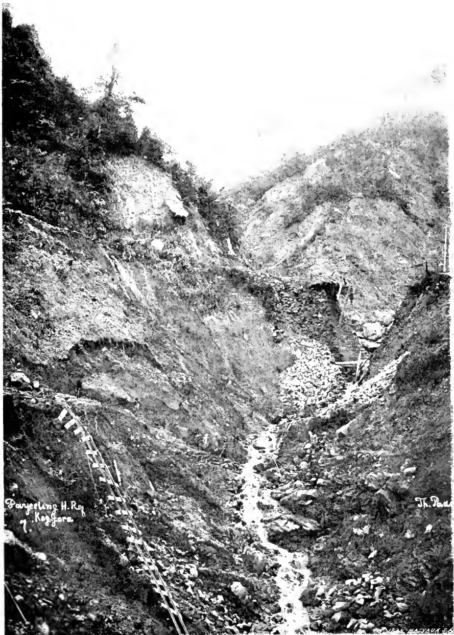
LA LIGNE DU CHEMIN DE FER APRÈS LES ÉBOUEMENTS
