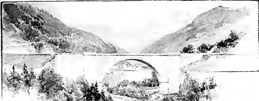
Abb. 58. Die Stephans- brücke.
