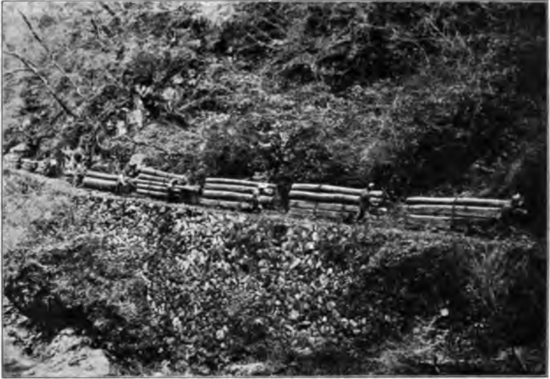
Abb. 60. Schlittentransport auf Trockenbahn.
