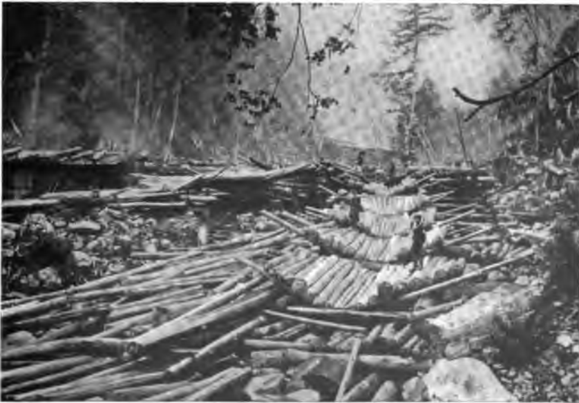
Abb. 55. Provisorische Holzriege in Kiso.
