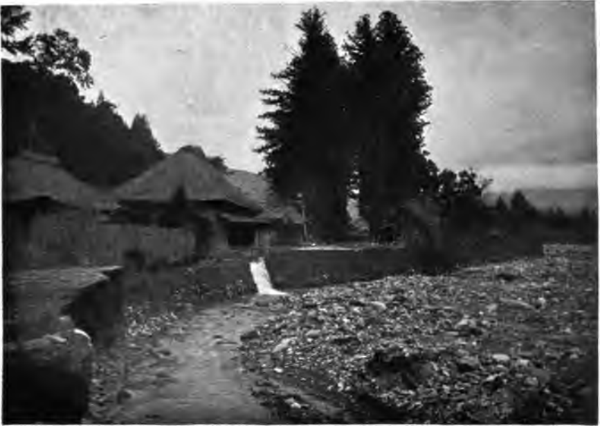
Abb. 74. Seitliche Erosion im Daiyagawa unterhalb Nikko. (Ausbruch in die berühmte Kryptomerienallee.)
