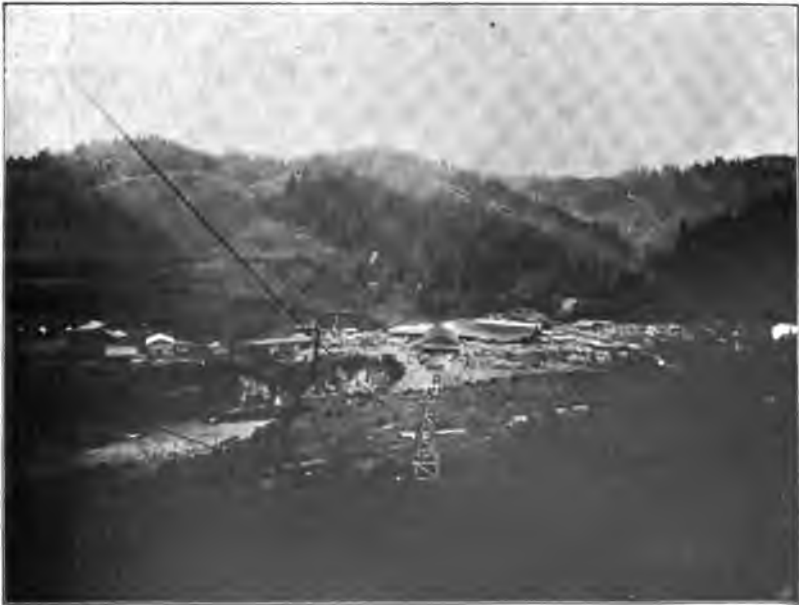
Abb. 67. Drahtseilbahn zur Erz- und Holzförderung in Kosaka.
