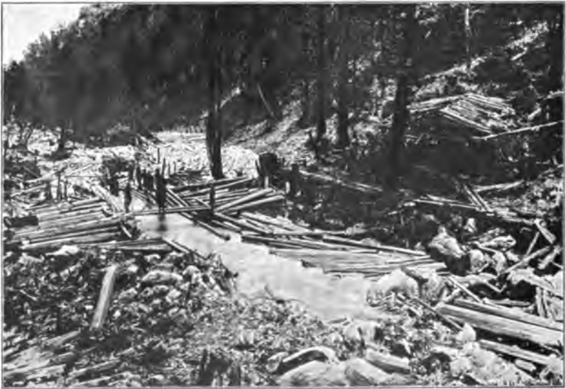
Abb. 57. Einleitung von Wasser in die Riesbahn.
