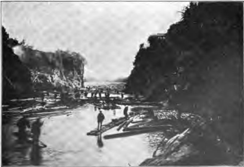
Abb. 63. Rechenhof bei Nishigori (Kisofluß); Binden des Triftholzes zu Flößen.
