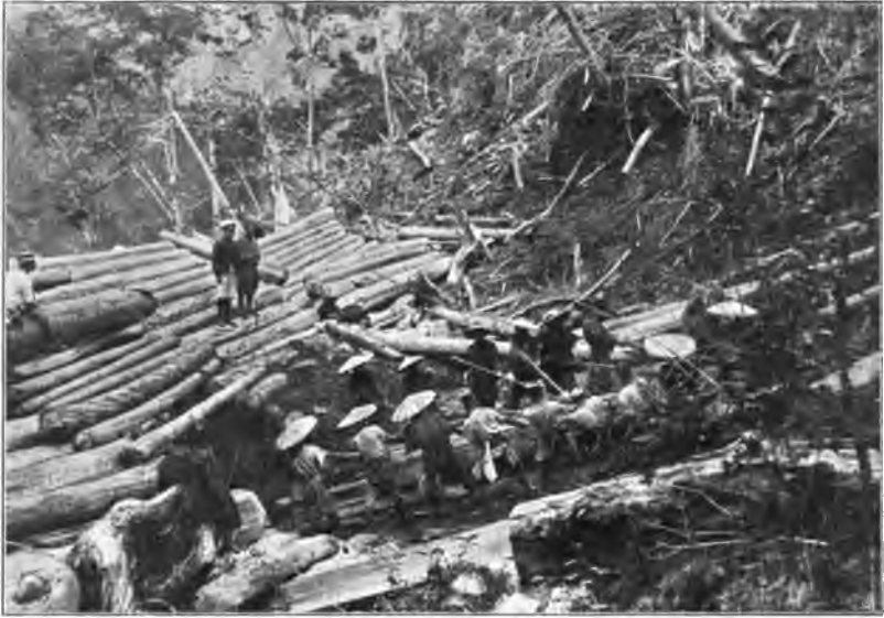
Abb. 56. Holzfang, geöffnet, mit Einführung des Stammes in die Riese.
