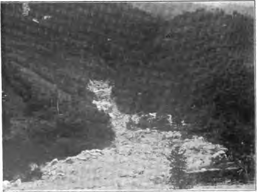
Abb. 75. Murbach im Kisotale. Die Massentransporte sind auf die Absitzung vollkommen bestockter Einhänge zurückzuführen.
