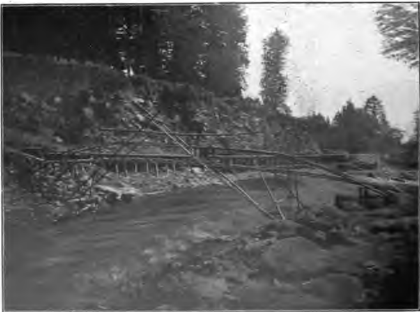
Abb. 79. Zerstörung der Talstraße von Nikko nach Chuzenji infolge Lateral-erosion des Dayagawa.
