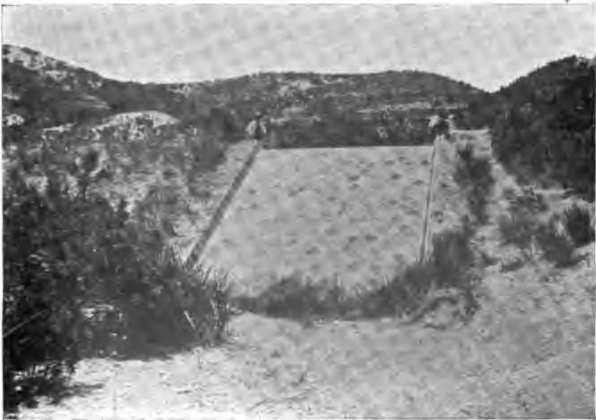
Abb. 85. Erddamm mit Kunststeinpflasterung. (Seto, Provinz Aichi).
