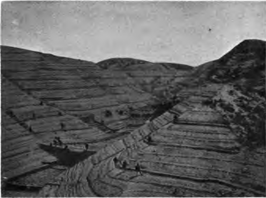
Abb. 90. Verbauungsperimeter bei Seto, unmittelbar nach der Ausführung.
