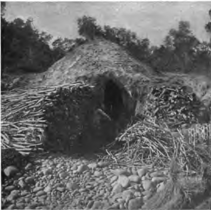
Abb. 51. Gemauerter Meiler zur Verkohlung in Formosa.
