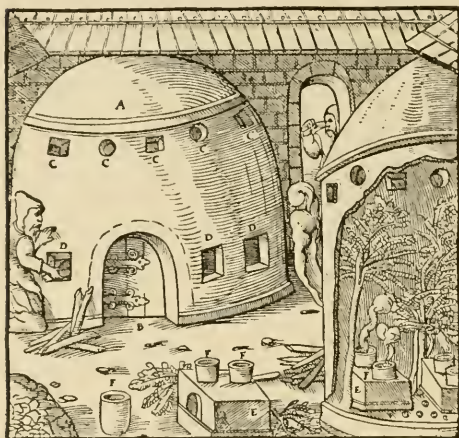
Fig. 44. Ofen zur Quecksilbergewinnung durch Sublimierung nach einem Holzschnitte vom Jahre 1557.
