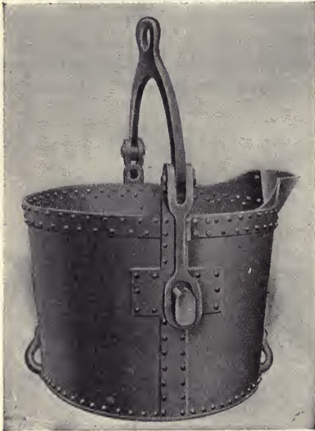
FIG. 222.—Crane Ladle.
