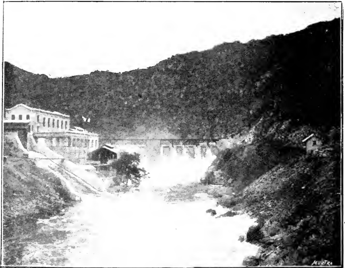
San Roque Dam (Córdoba).
