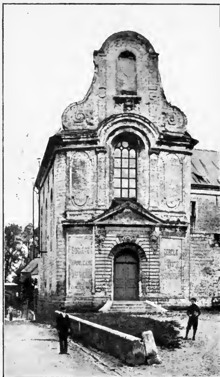
Fig. 83.—Montreuil-sur-Mer. S. Austreberthe.
