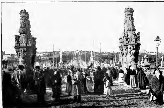
Fig. 90.—Madrid. Puente de Toledo. (See p. 188.)
