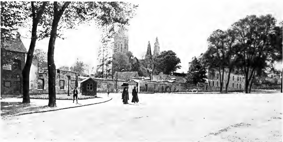
Entrance to the Rue de la République after the Fire
