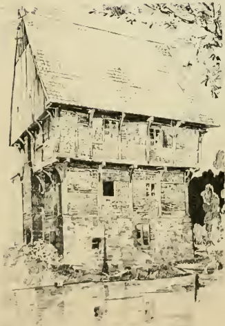
Speicher 1 , gothisch, Fachwerkbau auf massivem Untergeschoß. (Abbildung nebenstehend.)
