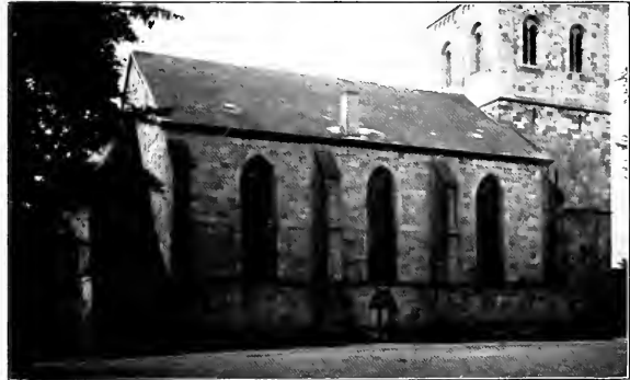
Nordostansicht der Kirche.
