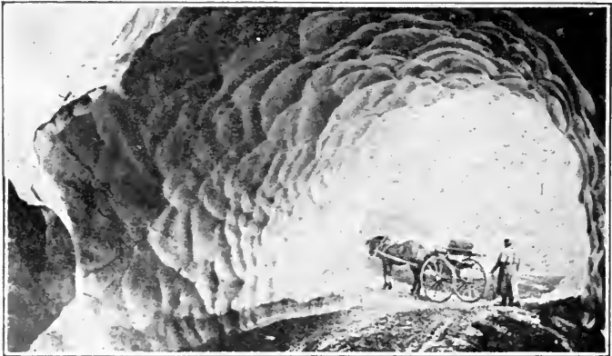
Snetunnel ved Haukelid.
