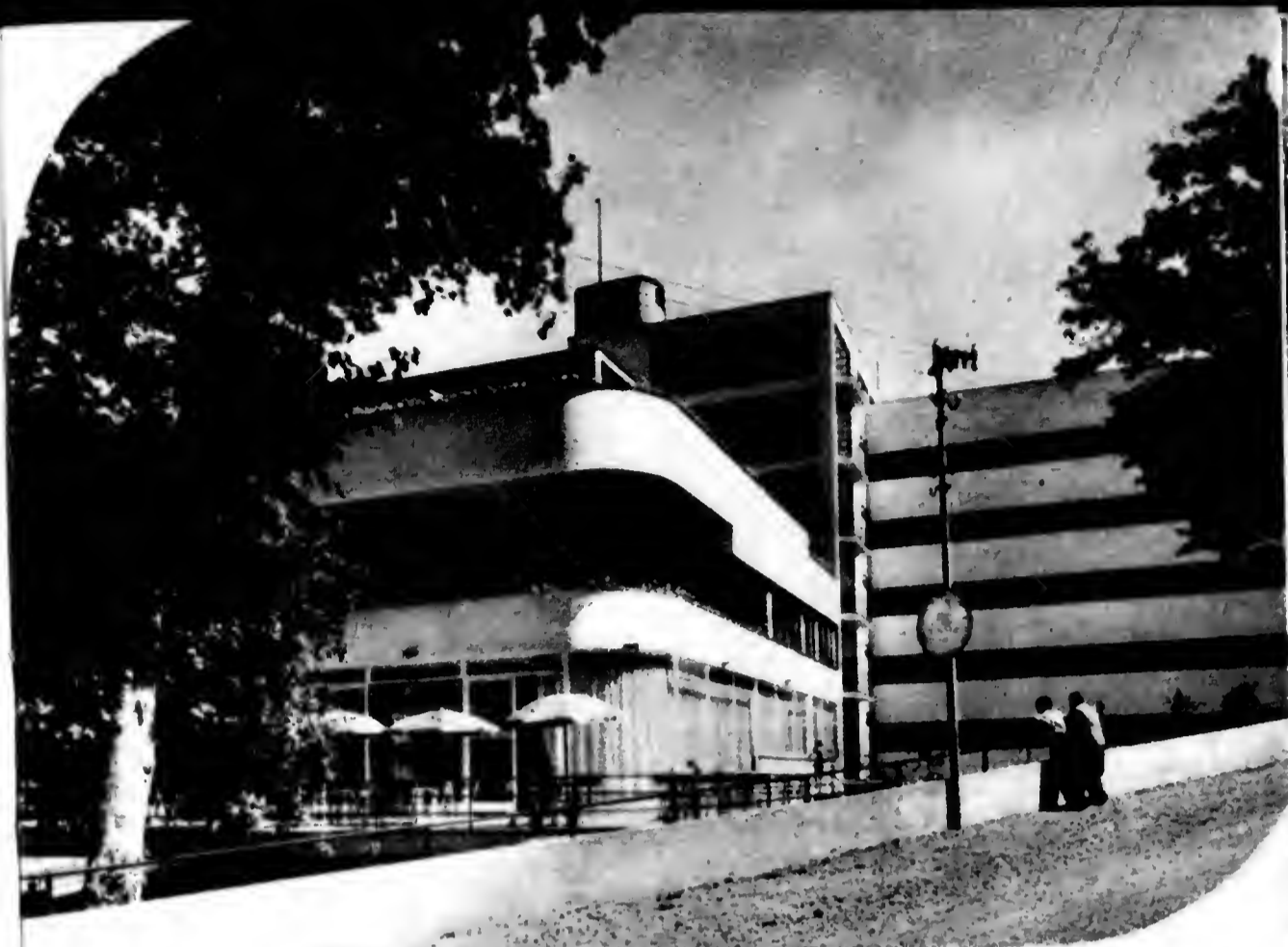
Trenčianske Teplice, moderná kúpeľná architektúra
