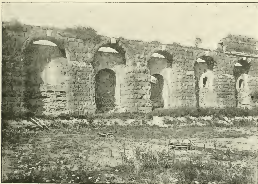
FIG. 6. — Aqueduc de la Claudia, entre la Porte Prænestina et le saillant Sud-Est. Vue intérieure à la suite de la construction de l'Enceinte d'Aurélien.
