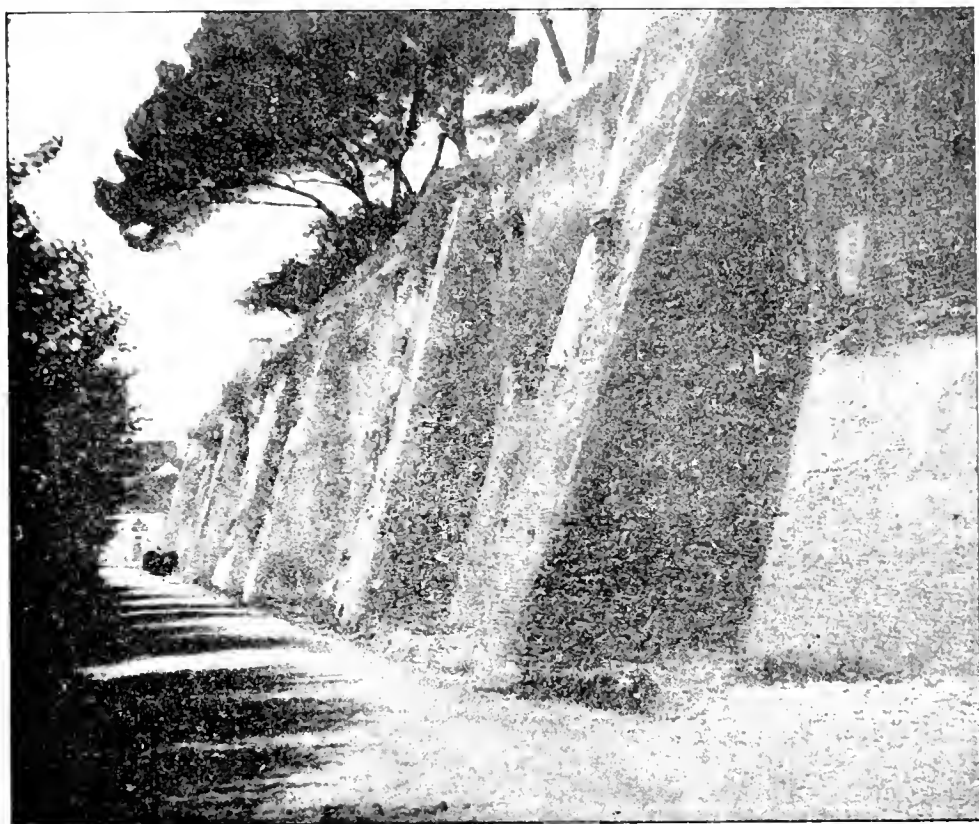
FIG. 16. — L'Enceinte d'Aurélien, entre la Porte Asinaria et les substructions de la Domus Lateranorum.
