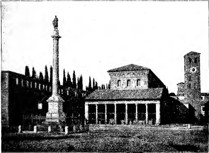
Bild 45. S. Lorenzo vor den Mauern Roms.
