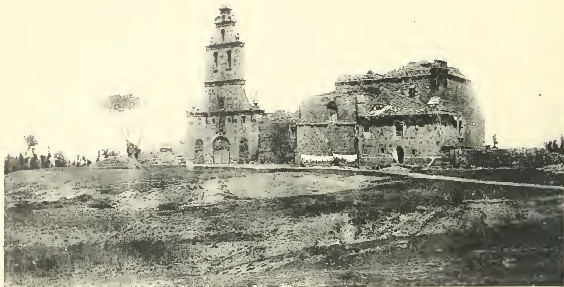
Ruinas del Convento.
