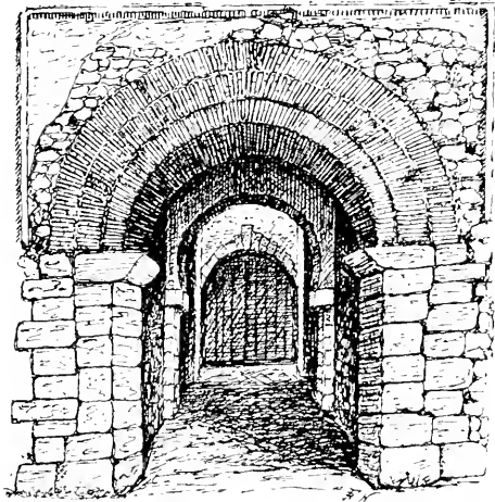
PUERTA PRINCIPAL DE LA FORTALEZA DE MAQUEDA
