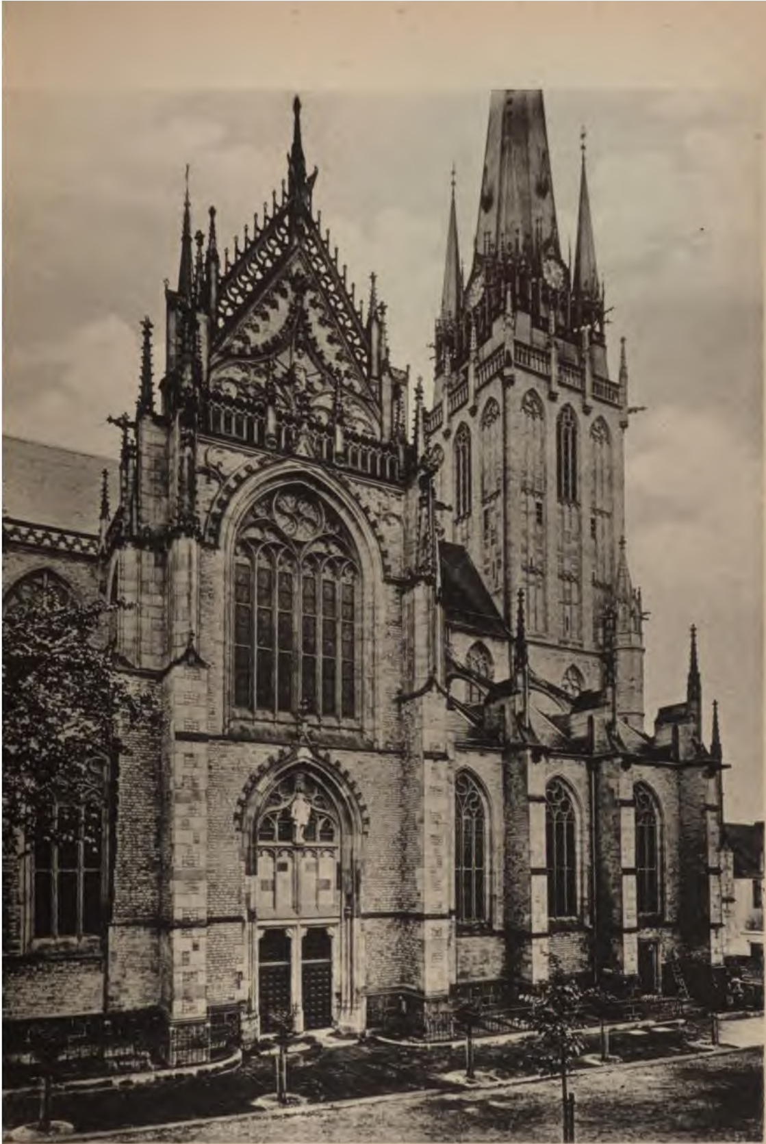
Wesel. Die Nordseite der Willibrordikirche nach der Restauration im Jahre 1896.
