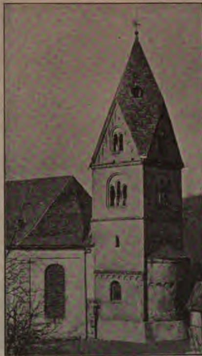
Fig. 23. Oberdollendorf, kath. Pfarrkirche. Ansicht des Turmes vor der Wiederherstellung.
