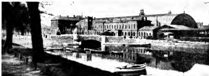
Banhallen i Malmö före rivningen 1921.
