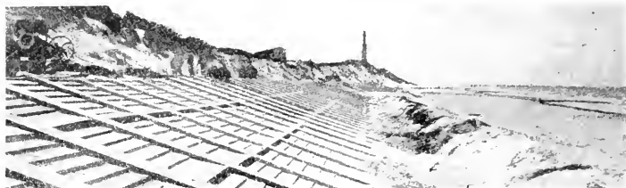
Nederländerna. Betongfördämning på ön Schouwen.
