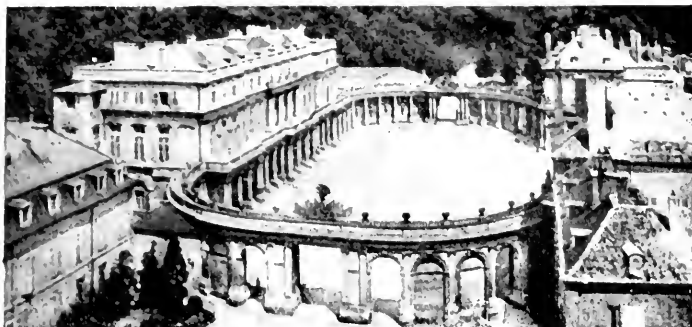
Nancy. Place de la Carrière med regeringsbyggnaden.
