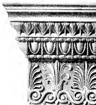
Grekiskt antekapital med lesbiskt (överst) och joniskt kymation (läggstav), pärlstavar och i akantusformer ombildad lotus-palmettbård. Erektion, Aten.
