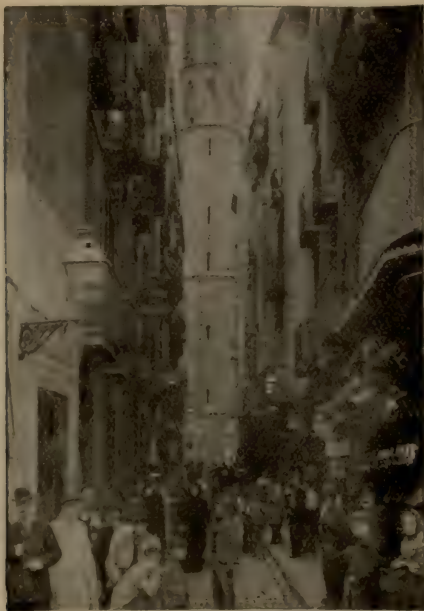
La ville : rues étroites et insuffisamment aérées.
