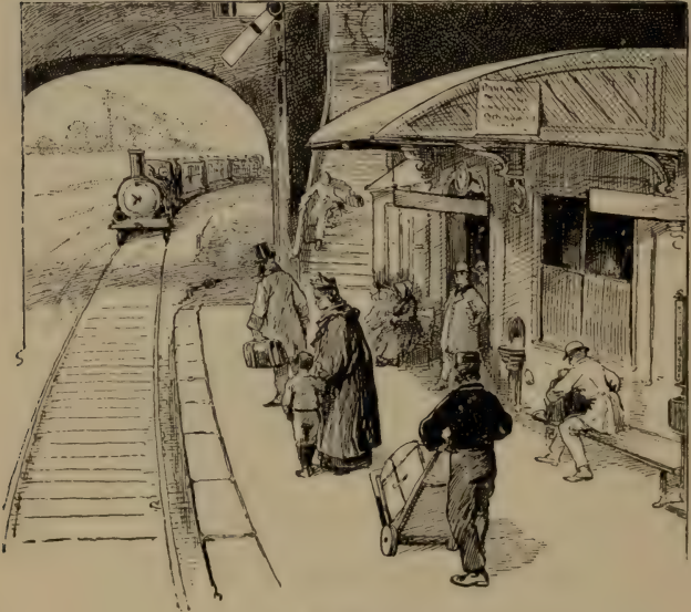
Intérieur de la gare : le quai.
