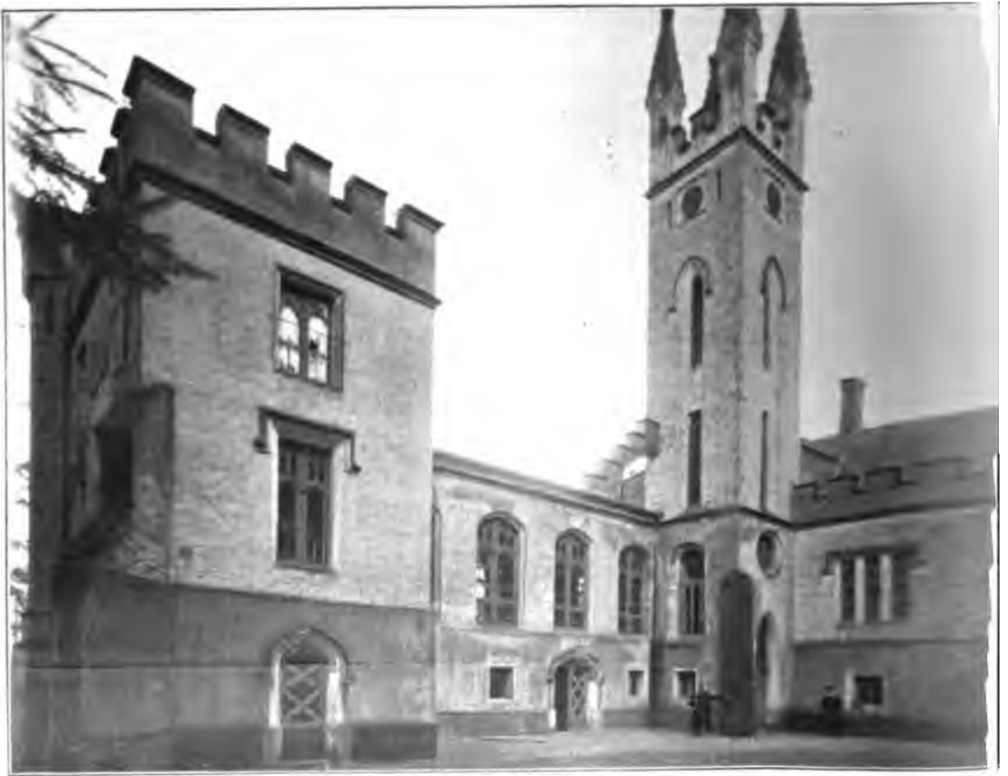
27. Williamscastle (Richmond) von Südwest.
