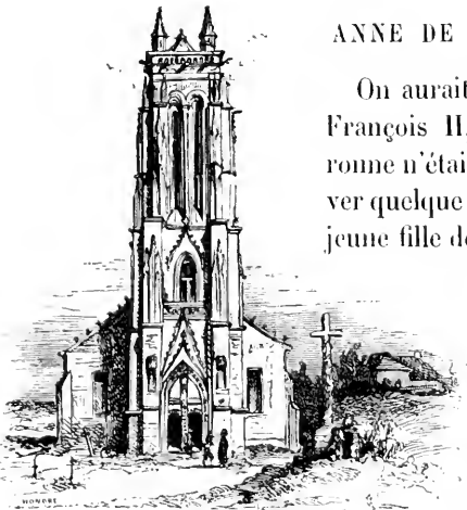
Tour de Saint-Tromeur, à Carhaix.
