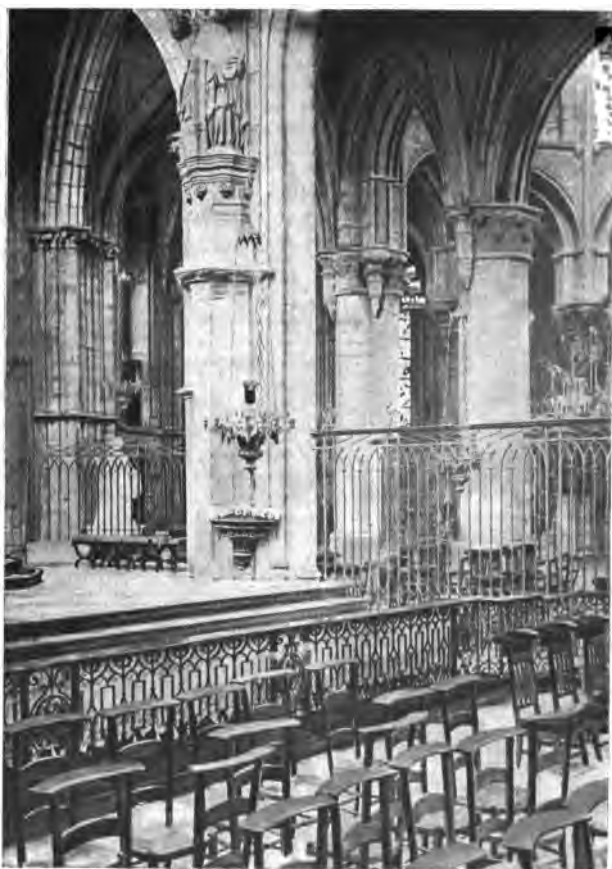
L'ABSIDE VUE DE LA CHAPELLE DU SAINT- SACREMENT.
