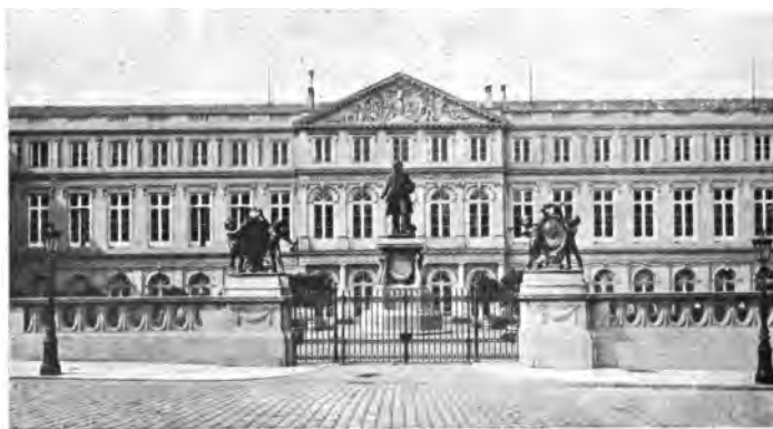
LA FAÇADE DE LA BIBLIOTHÈQUE ROYALE.
