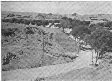
Wegebauten in Tsintau.*) (Weg zur Clarabucht, Schlucht.)
