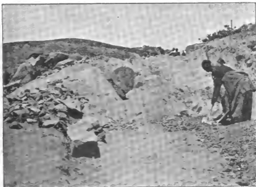
Wegebauten in Esmant.*) (Weg zur Clarabucht, Felshindernis.)
