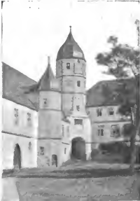
Abb. 38. Haigerloch, Fruchtkasten oberer Torturm und Hofkaplaneigebäude.
