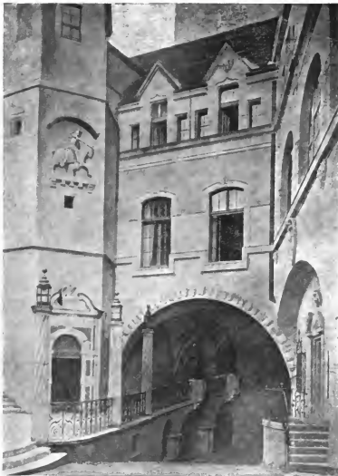
Abb. 27. Ansicht des inneren Schlosshofes in seiner neuen Gestaltung.
