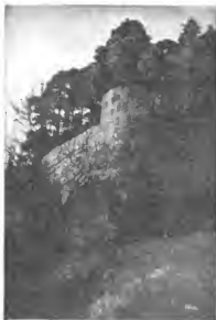
Abb. 139. Teilansicht der Burg Wehrstein beim Eingang.
