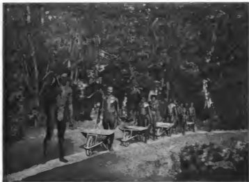
Eingeborene an einem Wege arbeitend.
