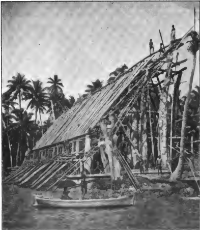
Bau eines großen Gemeindehauses.
