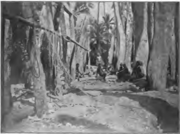
Bau eines großen Gemeindefaßes, das Aufrichten der großen Stützpfiler aus Nienbaumstämmen. Augenblicklich „Pause“.
