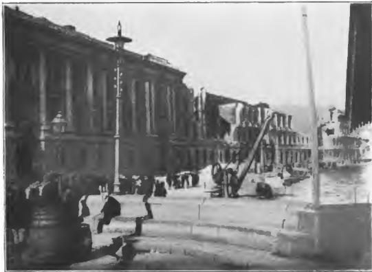
Messina. Zerfallene Hafenmauer.
