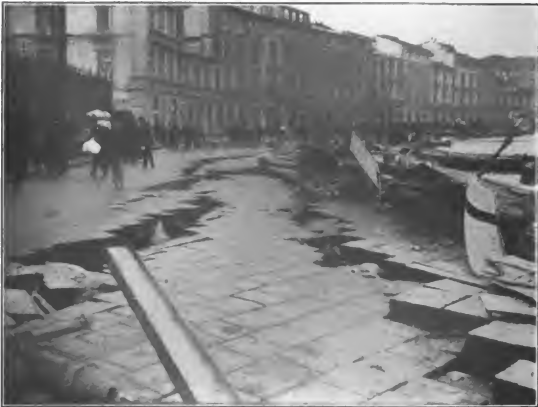
Messina, Spaltenbildung am Hafen, an der auseinander gerissenen Pflasterung erkennbar.
