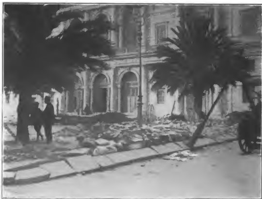
Messina am 2. Januar 1909. Piazza del Municipio. Die Pflastersteine sind dachartig gegeneinander geschoben.
