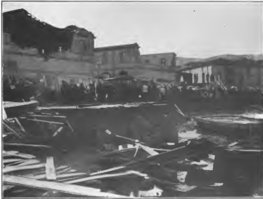
Abgerutschtes Terrain am Hafendamm von Messina.
