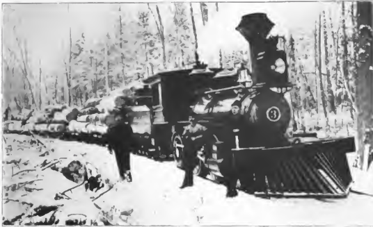
Schmalpurbahn zur Holzabfuhr in den Wäldern von Wisconsin
