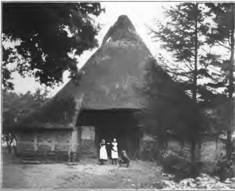
Niederfächsisches Bauernhaus (Fachwerk mit vorgebauten Schweineloſen)
