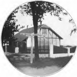
Zweifamilienhaus aus Albest, vom Fiskus erbaut
