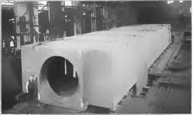
Ein Kiefengeldschrank: Panzerplattengewölbe, ausgeführt für die Carnegie Safe Deposits Company in New York
