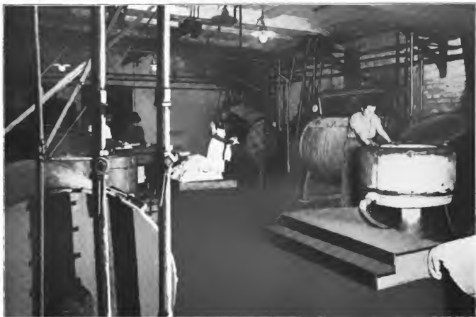
Waschraum mit Handwäsche, Waschmaschinen und Zentrifugen
