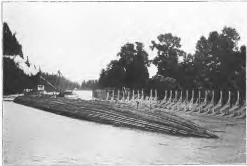
Ein 300000 Fuß Bauholz enthaltendes Floß; neben ihm das Raugerüst
