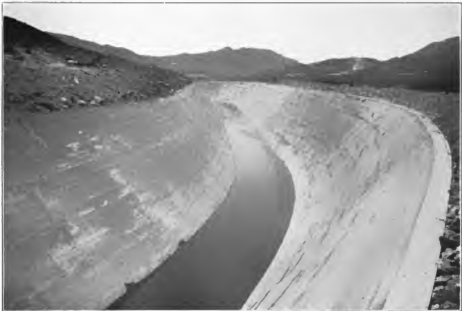
Kanal, durch den das Wasser des Truckeeflusses in Nevada 80 Kilometer weit fortgeleitet wird
