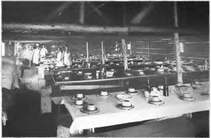
Speisesaal in einem Holzfällertager; im Hintergrunde die Röhre
