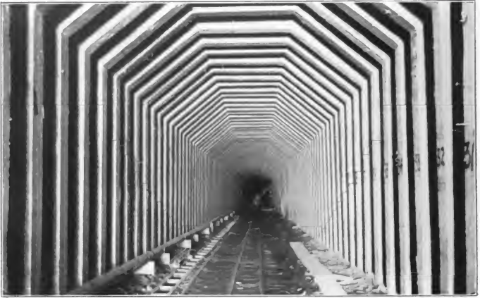
Unterirdischer Leitungskanal für das Wasser des Gunnisonflusses
