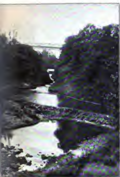
Hohe Brücke über die Dobraschlucht in Ogulin.
