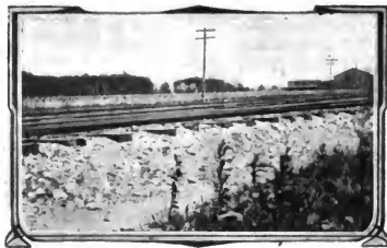
Fig. 44. Eisenbahndamm, von Austernschalen gebildet.
