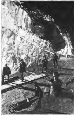
Wegarbeiten in der Tominsgrotte.
