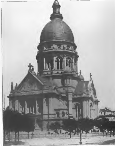
Die neue evangelische Christuskirche in Mainz. Erbauft nach Plänen von Saurat Kreyffig
