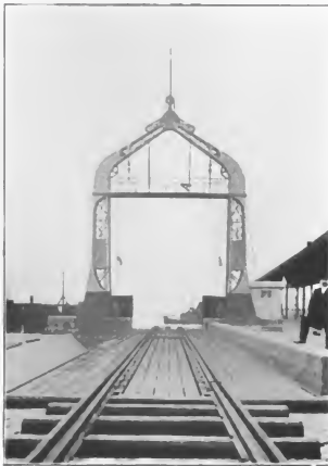
Das Hebewerk für die Eilenbahnchienen
