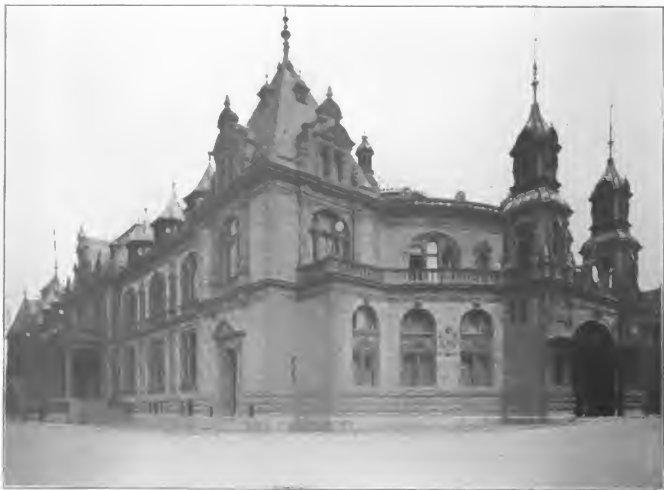
Die neue Stadthalle in Heidelberg. Nach den Plänen von Denckenhof und Ebert
