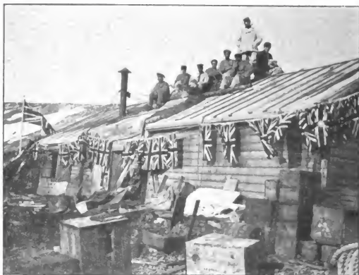
Auf dem Dach der Hütte Neujahr 1900 (Photographie)
