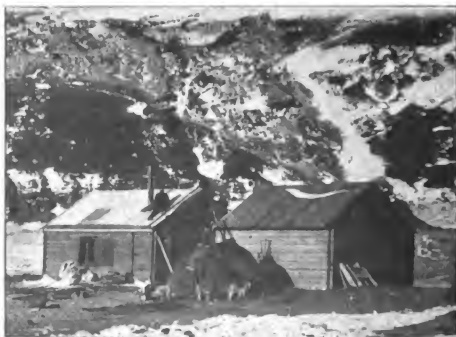
Die norwegischen Holzhütten am Kap Adare (Photographie)
