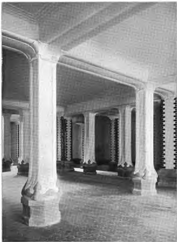
SÄULENPARTIE IM KELLERGEHOSS
