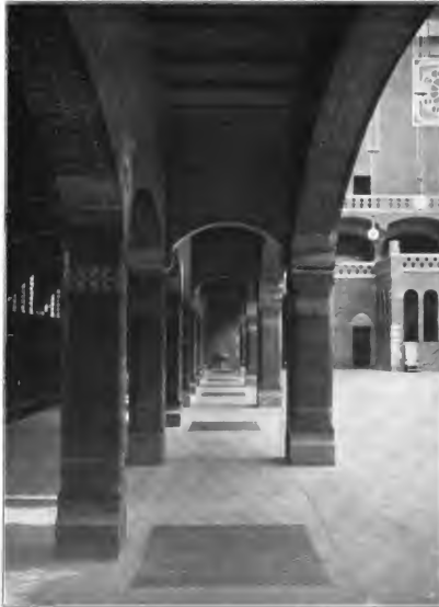
BLICK DURCH EINE DER UNTEREN SEITENGALERIEN DER WARENBÖRSE
