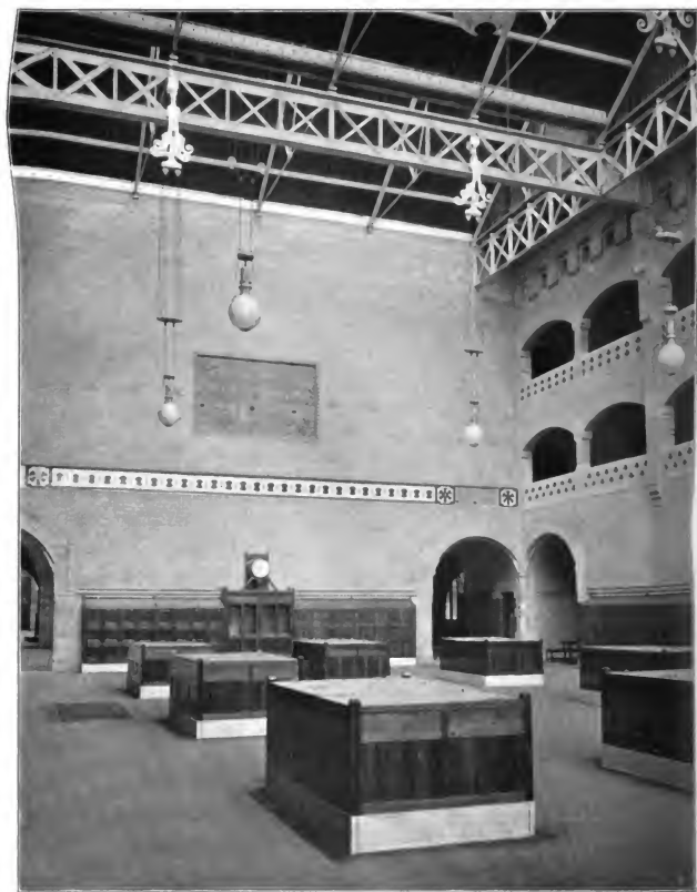
H. P. BERLAGE • NEUBAU DER AMSTERDAMER BÖRSE: GROSZE HALLE DER GETREIDEBÖRSE BLASZGELBER BACKSTEIN MIT FRIES AUS FARBIGEN FLIESEN. IN DAS LEERE FELD DER RÜCKWAND WIRD EIN GROSZES RELIEF VON ZYL. EINGEFÜGT WERDEN •••
