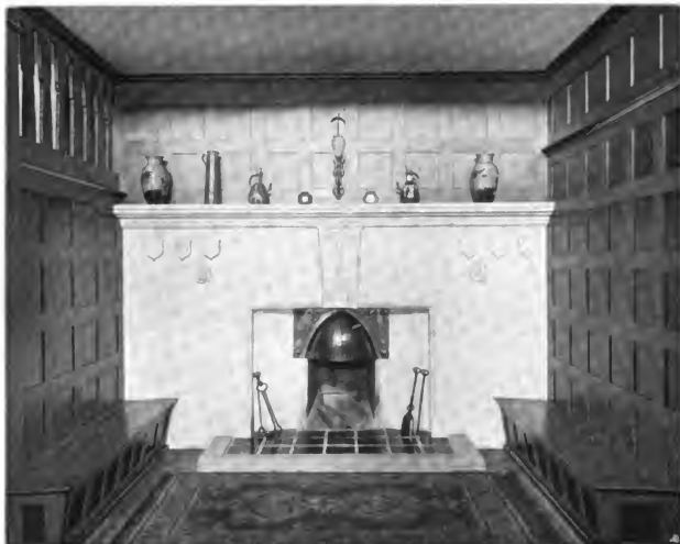
J. CROUCH & E. BUTLER, BIRMINGHAM • KAMINECKE IN DER HALLE EINES LANDHAUSES IN FOUR OAKS • KAMINMANTEL AUS GELBEM SANDSTEIN MIT KUPFERDACH • • • • •
