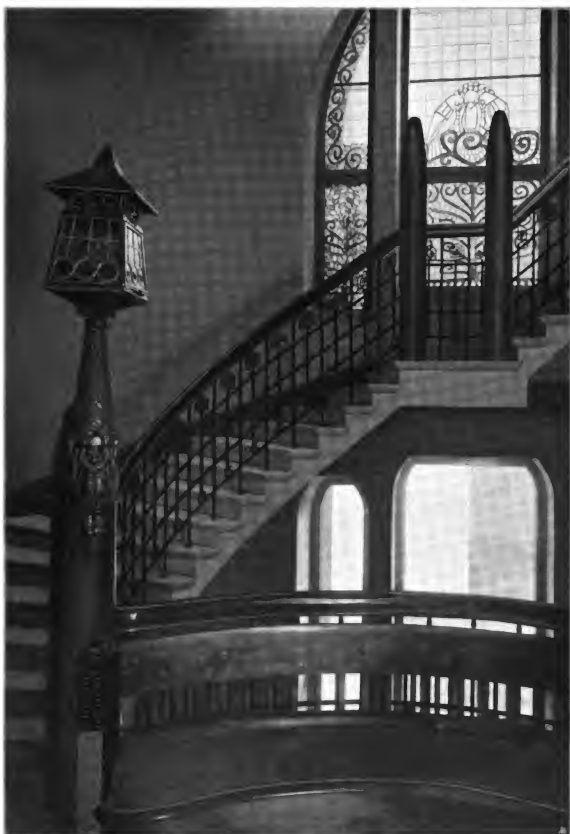
GESCHÄFTSHAUS DER AKTIENGESELLSCHAFT «POHJOLA»: HAUPTTREPPE ■ ERBAUT VON DEN ARCHITEKTEN GESELLIUS, LINDGREN & SAARINEN, HELSINGFORS ■■■■■
