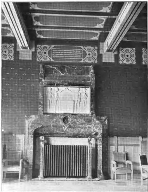
H. P. BERLAGE • DER VORSTANDSAAL DES EFFEKTEVEREINS: KAMIN AUS BRAUN- ROTEM UND GRÜNEM MARMOR, EINFASSUNG DES HEIZKÖRPERS AUS MESSING ●●● (DAS PROVISORISCHE GIPSRELIEF VON MENDES DA COSTA WIRD DURCH EIN BRONZERELIEF ERSETZT; DAS VIERECKIGE MITTELFELD IST FÜR EIN VENTILATIONSGITTER BESTIMMT) ●●●
