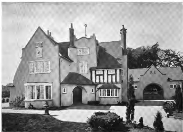
J. CROUCH & E. BUTLER, BIRMINGHAM • LANDHAUS IN FOUR OAKS • GARTENFRONT MIT GRUNDRISS
