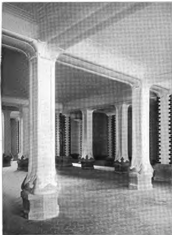
SÄULENPARTIE IM KELLERGEHOSS
