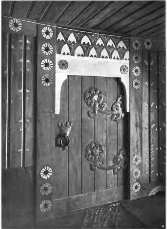
A. GOLOWINE • TÜR IM »TEREM« MIT GEHÄMMERTEN KUPFERNEN BESCHLÄGEN UND BEMALTEN HOLZSCHNITZEREIEN • • • • • AUSGEFÜHRT VON L'ART MODERNE, ST. PETERSBURG
