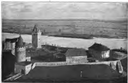
Abb. 3. Nach der Wiederherstellung.
