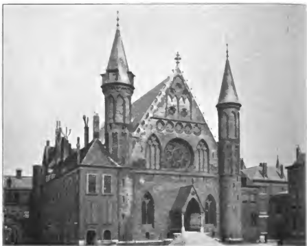
Abb. 2. Der Rittersaal vor der Wiederherstellung (1895).
