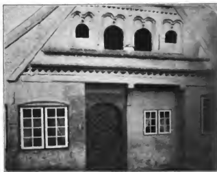
Abb. 12. Haus in der Nordevstraße in Meldorf (1579).
