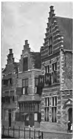
Abb. 6. Häuser am Halbnplatz in Middelburg.
