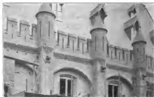
Abb. 5. Der wiederhergestellte Wohngang 1900.
