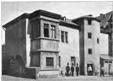
Abb. 2. Der „Bickenbau“ in Mainz.
