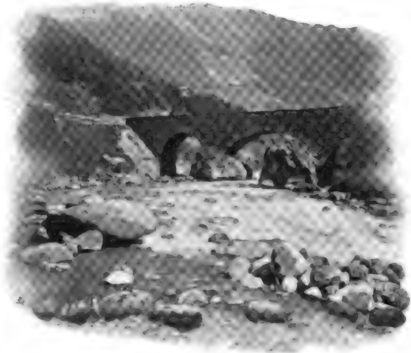
Alte Brücke bei Engi im Sernstal.
